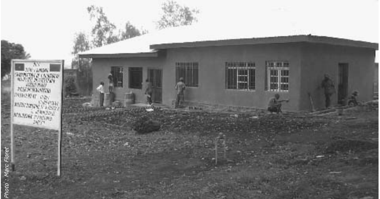
Photo : Marc Floret Construction du Tribunal militaire de Bunia, 2005,
